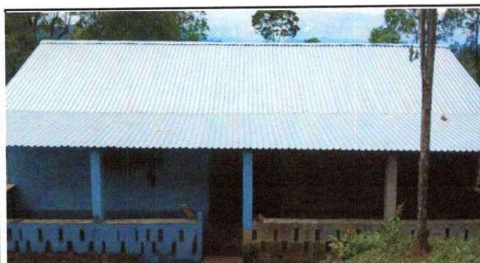
Foto 3: Se culmino con la sustitución de lámina, por lámina troquelada aluzink calibre 26 original. Módulo 2
