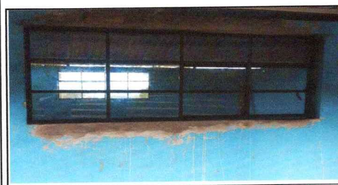
Foto 5: Se culmino con la fabricación de ventana de metal con marco de angular de 1 pulgada, con vidrios transparente.
