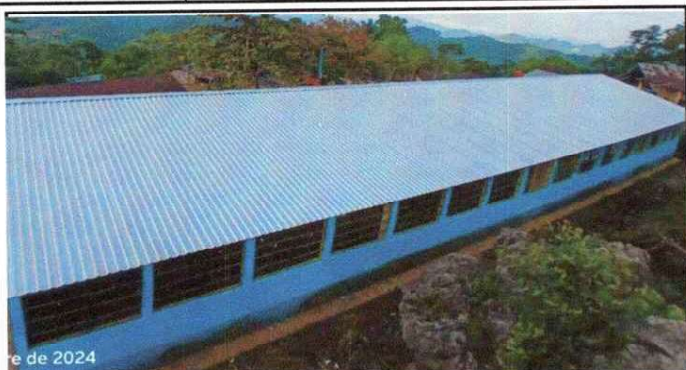
Foto1: Se culmino la sustitucion de lámina, por lámina troquelada aluzink calibre 26 original. Módulo 1
