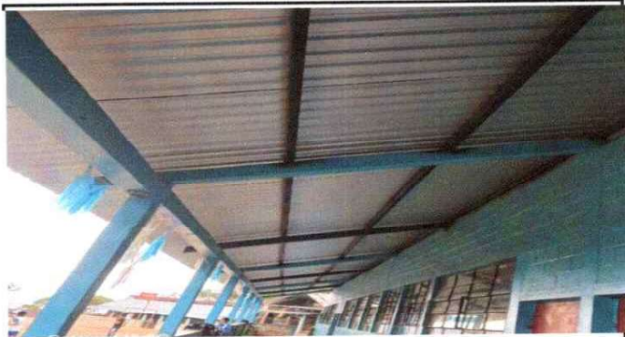
Foto 2: Se culmino el mantenimiento de estructura de soporte Módulo 1
