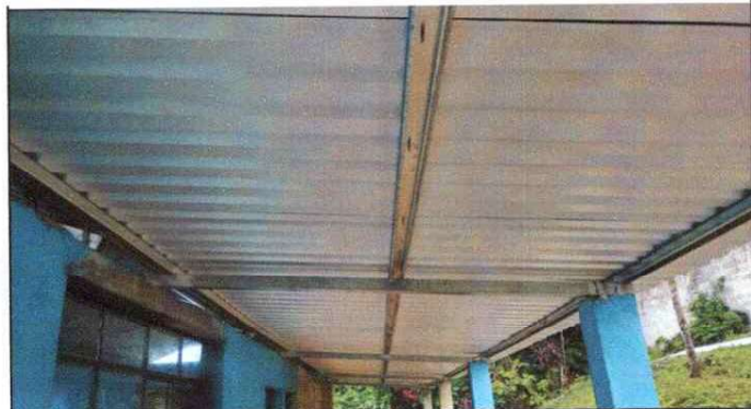
Foto 4: Foto 4: Se culmino con la sustitución de estructura de soporte de madera, por metal.
